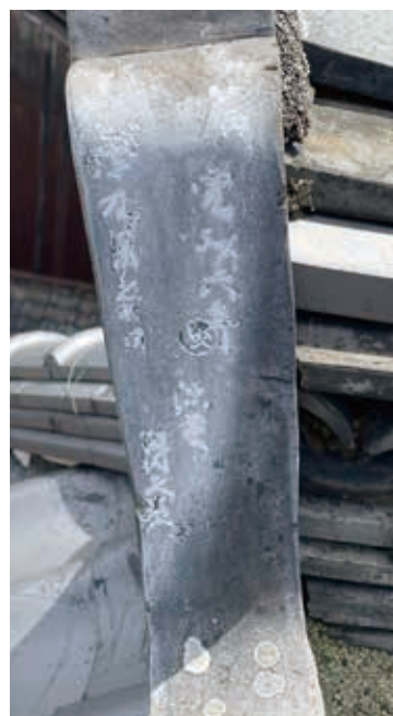
図6 玄関北端獅子口西面
