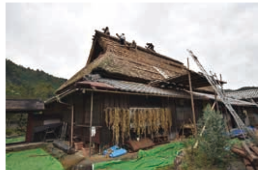
写真9 茅葺屋根の葺替え：河原林家
