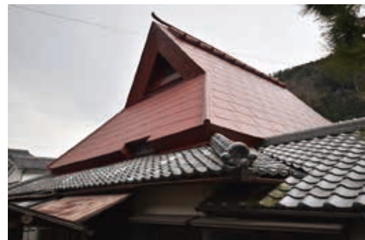
写真10 鉄板葺屋根の修理
