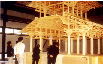
五分の一構造模型による復原第一次大極殿の検討
