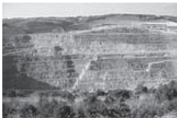
図-4. 住金鉱業㈱住金鉱山 （通称：八戸キャニオン：青森県八戸市）
