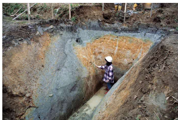
第 1 図 生駒断層の検出状況
