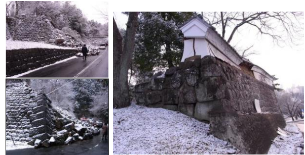
第18図 東日本大震災による被災状況
