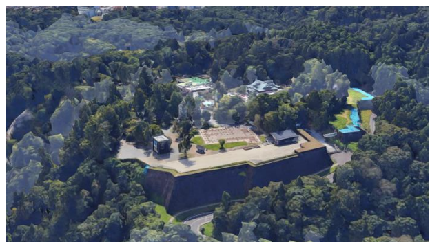
第 17 図 修復後の本丸北東部石垣（2023 年）
