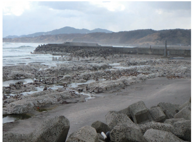
②輪島市名舟漁港（輪島市名舟） 漁港全体が大きく隆起し、船の着岸ができなくなっている。輪島市西部では最大約4m隆起した。
