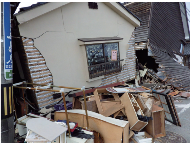
⑤輪島市河井町地区 河井浜に面する民家。1階部分はつぶれてしまっている。津波は来っていない。
