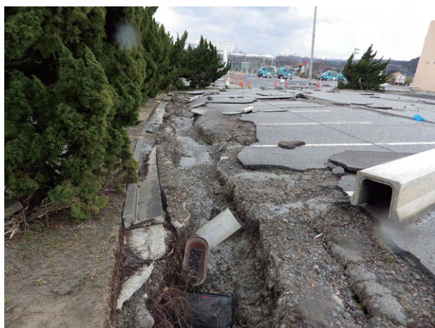
③地割れに生じた流路（落堀） 表層にはプランターやスーパーの買い物カゴ、植物遺体、コンクリート片、アスファルト片などが多数散乱している。
