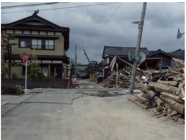
⑤丈六山妙厳寺門前（珠洲市宝立町鶴飼）液状化によりマンホールは突き出し、道路奥の寺の山門は崩落している。路面には津波堆積物の砂が広がっている。
