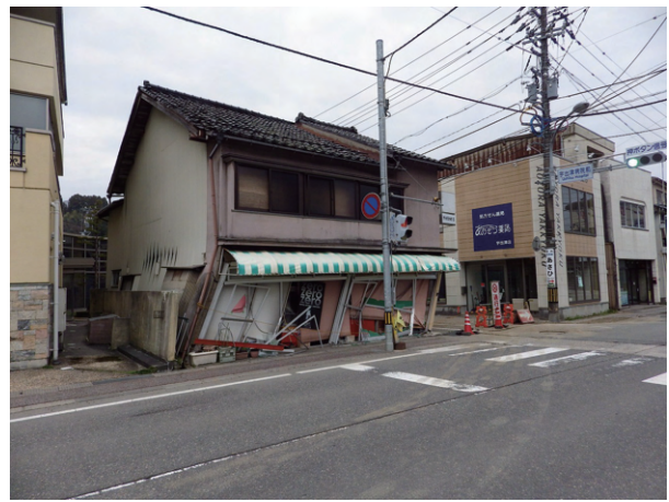
②宇出津病院前交差点（能登町宇出津）建物の応急危険度判定により、赤（危険）、黄（要注意）、青（調査済）の張紙が貼られている。
