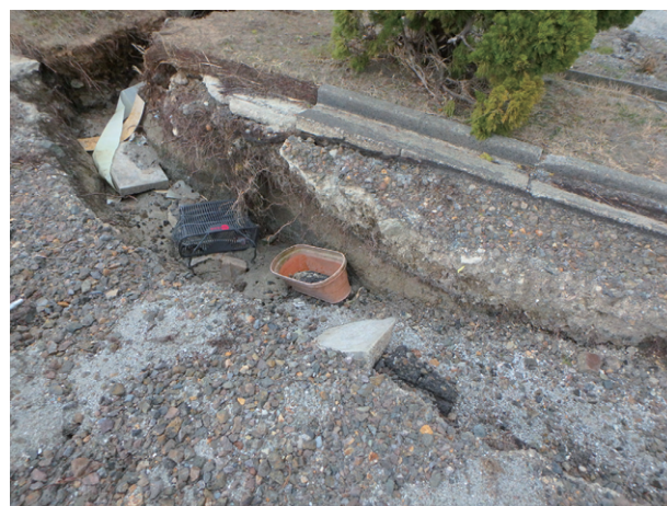
④地割れに生じた流路（落堀） 地割れに生じた戻り流れによる流路は縁石を壊し、隣の港の駐車場側（海側）へと続く。
