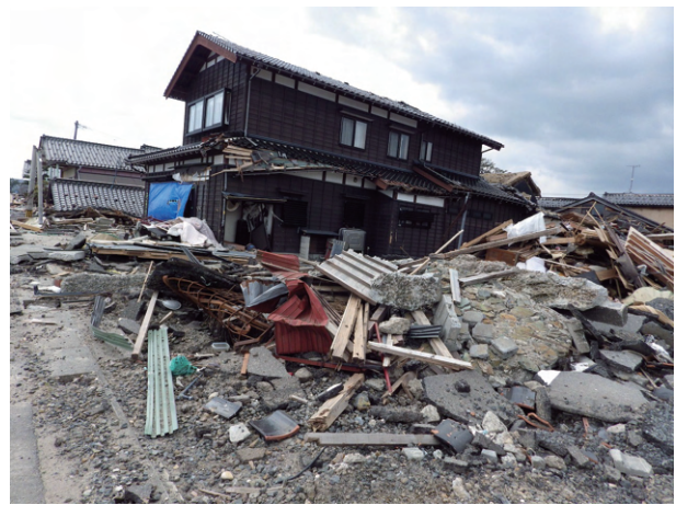
②鵜飼川に面する町並（珠洲市宝立町鵜飼） 鵜飼川の左岸堤防（写真左手側）を越えた津波は1階部分を突き抜けている。流出瓦礫顕著。津波堆積物は礫混じり。
