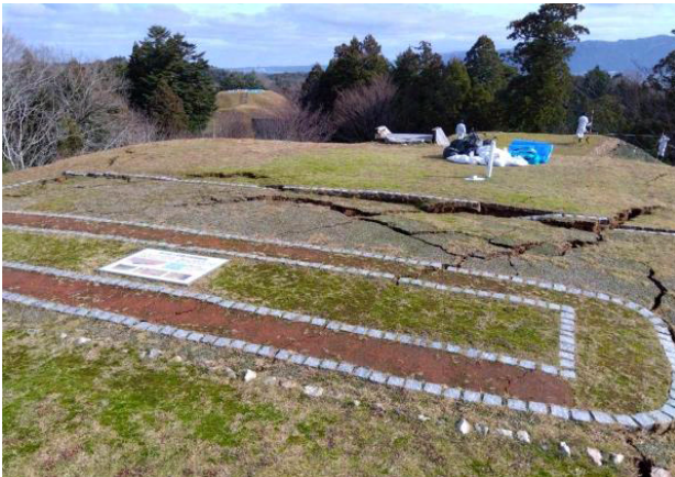
復元墳丘に無数の亀裂、葺石崩落
