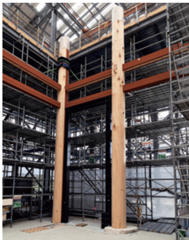
図59 東楼側柱の掘立柱（ニー）と礎石建ちの柱（ハー） （2023年9月7日撮影・南西から）
