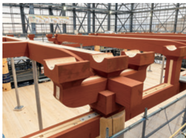
図60 東楼側柱上の組物（ニー）（2024年1月31日撮影・北東から）
