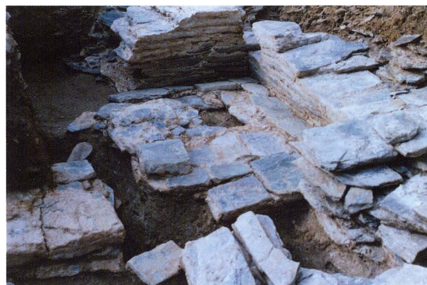
Fig.53 カツヤマ古墳の地割れ跡 （石室の床面が引き裂かれ、手前側が下降している）
