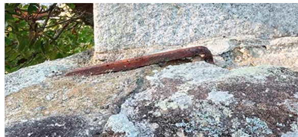
図3 鋸とモルタルによる部材の接合
