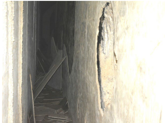
第3弾薬庫跡（剥離及びアスファルトフェルト）
