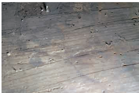
図19 稲荷社床板の台鉋の痕跡
