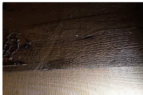
図20 稲荷社東側板の縦挽鉋の痕跡
