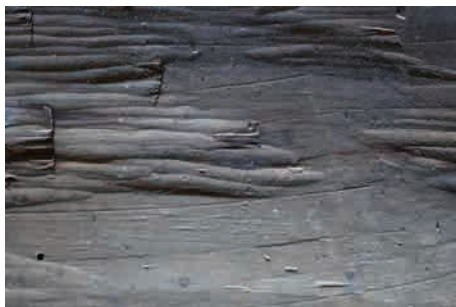
図 5 田中社床板の台鉋と槍鉋様の痕跡
