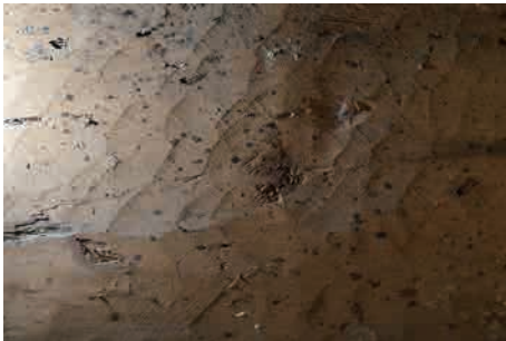
図13 柳社北側板の鉋の痕跡
