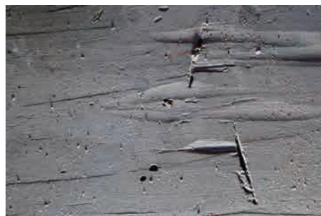
図12 柳社床板の台鉋と檜鉋様の痕跡
