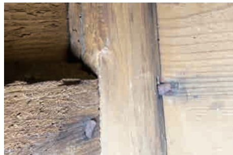
図18 稲荷社北西柱の台鉋の痕跡
