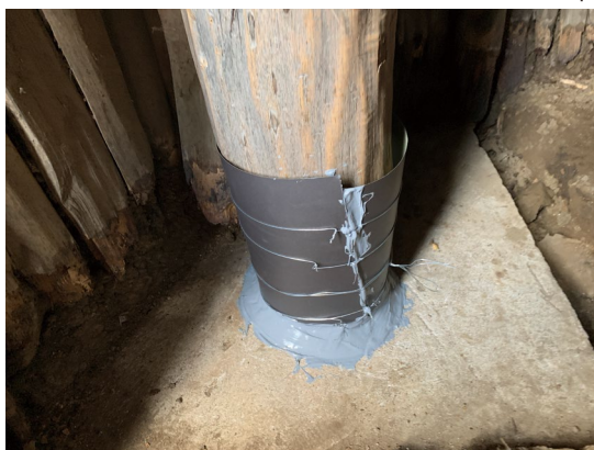
第 24 図 9号住居の柱木材の修繕
