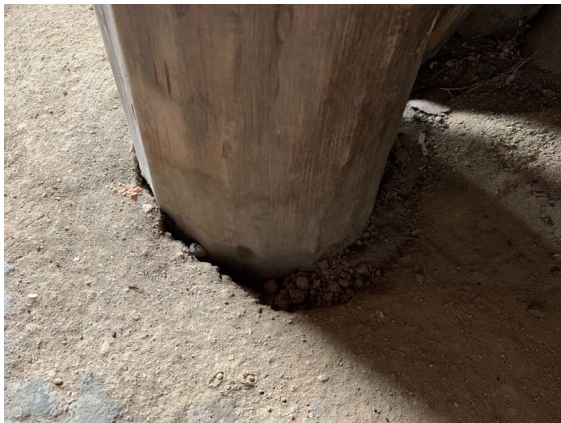
第1図 地震による被害（9号住居）
