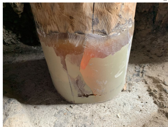
第 24 図 9号住居の柱木材の修繕
