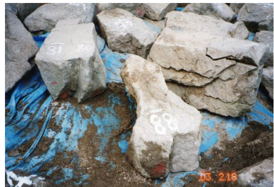
第 32 図 解体された石材（百間石垣）
