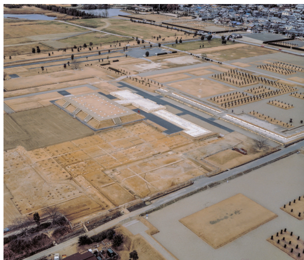
図 11 第二次大極殿の基壇及び周辺の整備状況(1983 年)
