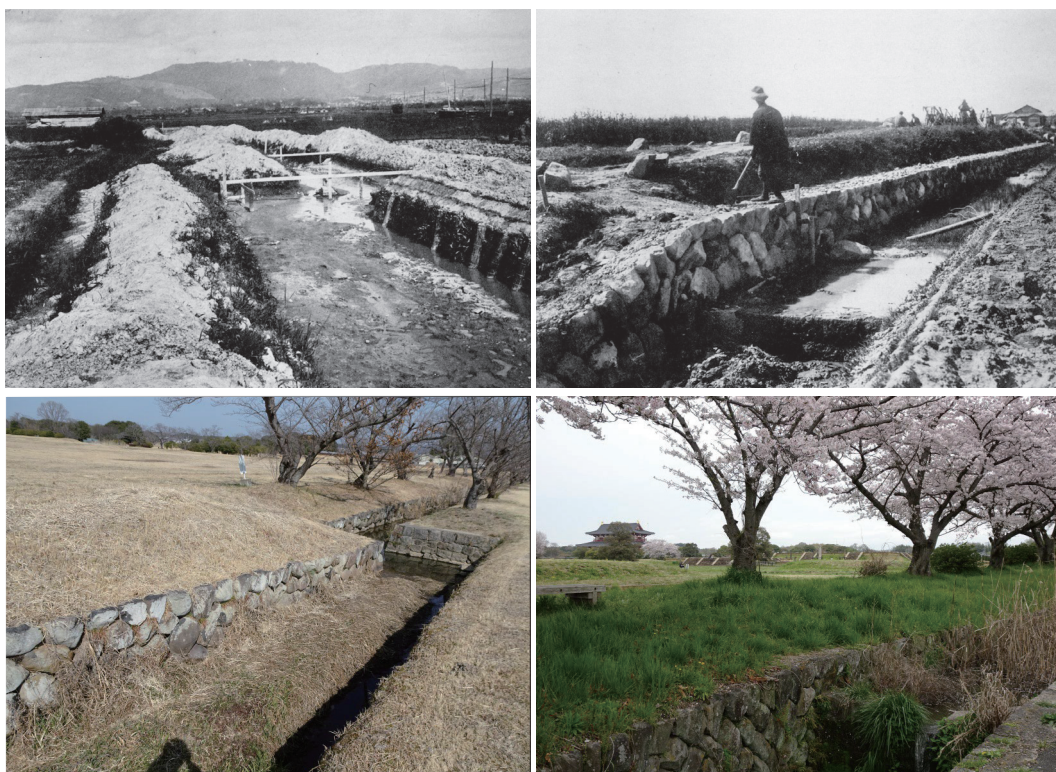
図 17 石積み溝設置工事と現状（左上、右上、左下写真は奈文研 2022 より）
