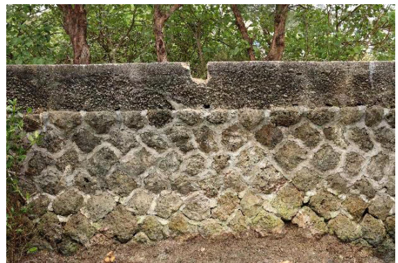
第3図 護岸に設置された銃座
