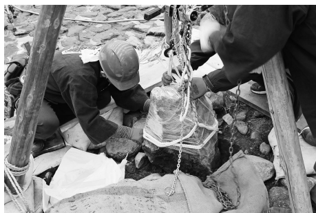
図9 景石の据え戻し（宮跡庭園）
