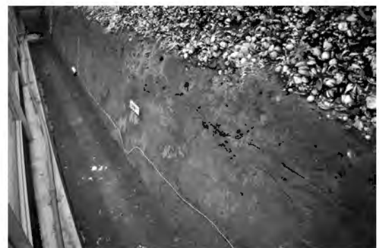
写真7 地衣類の発生状況②
