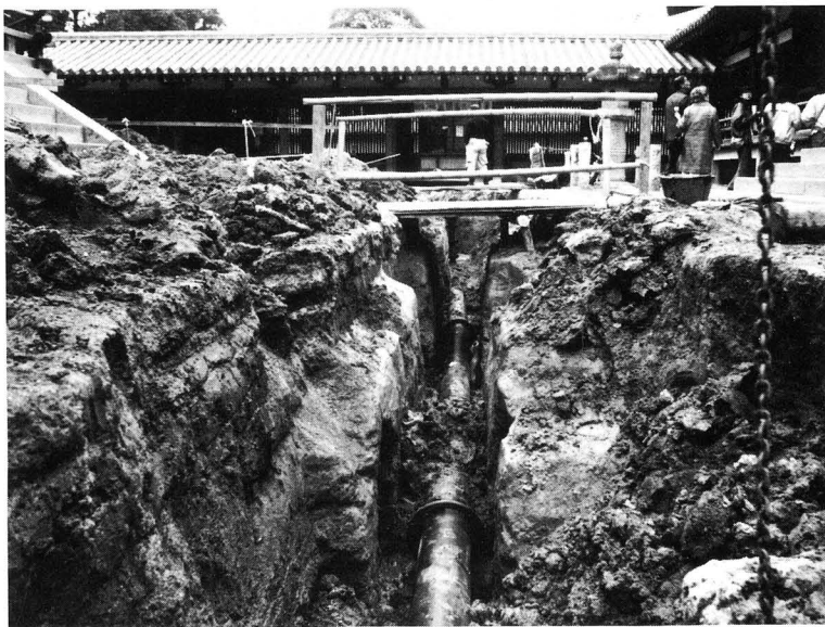
1. 東院の配管工事
