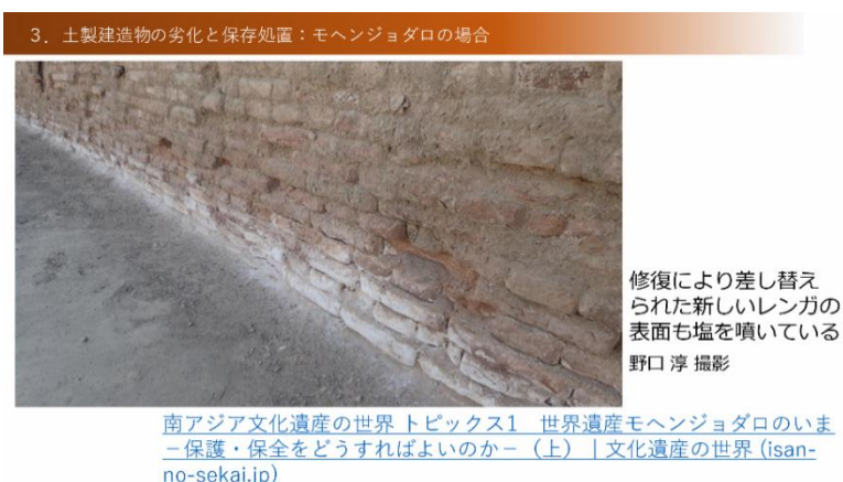
図21 モヘンジョダロの日干しレンガの塩類風化
