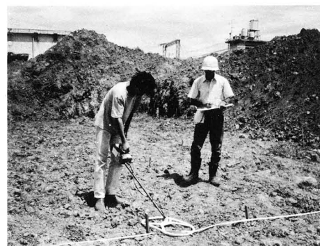
fig. 8 金属探知機による調査状況
