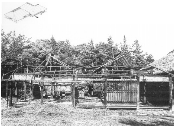
重要文化財・旧太田家住宅主屋の火災直後 (子どもの花火による火災:平成2年)
