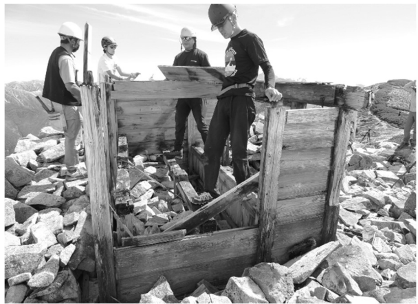
祠の解体作業
