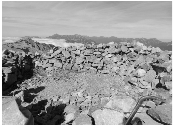
解体後の地面整地
