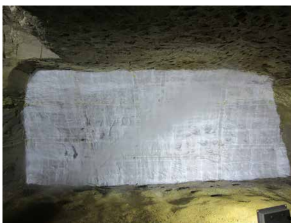
2-2. ビニロンクロス貼り込み作業完了状況
