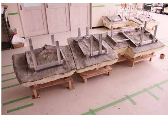
3. 【工程 3-(4)】骨組みの取付け③
