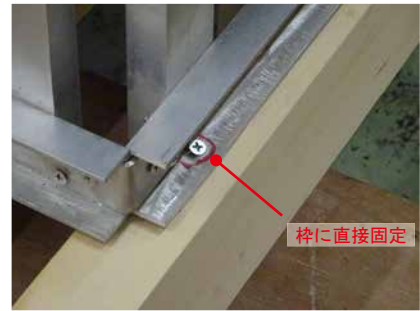
3. 【手順 5】 運搬用木枠固定状況 2
