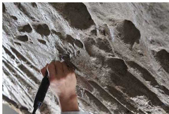
2. 【工程 7-(2)】マイクログラインダーによる加工
