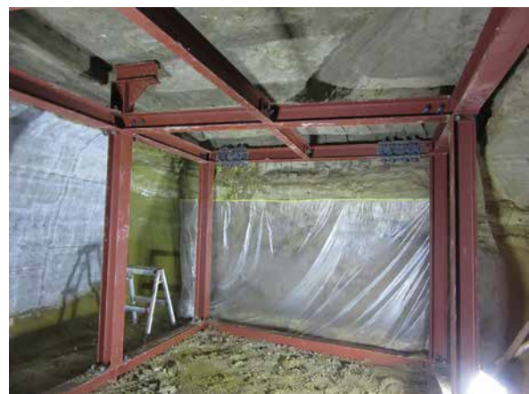
6. 支保工設置状況 (正面: 右側壁)
