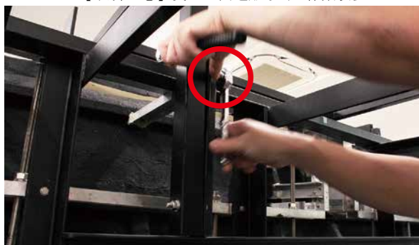
5. 【手順 7-②】 左側壁のボルト取外し作業
