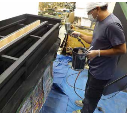
11. 【工程 9-(6)】 塗装作業状況 (側面)
