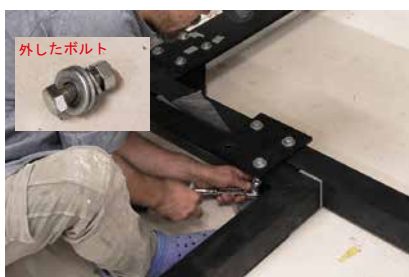
2. 【手順1】 連結パーツ取外し作業状況
