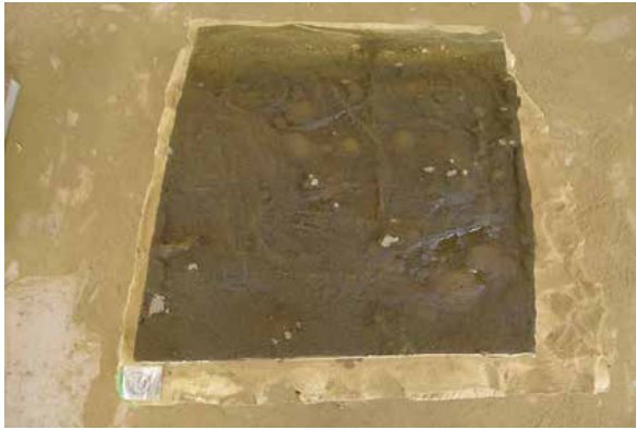
1. 【工程 3-(1)】アクリル樹脂塗布・含浸 (壁番号⑩)
