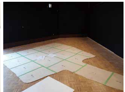
5. カーペット設置作業（施工前）
