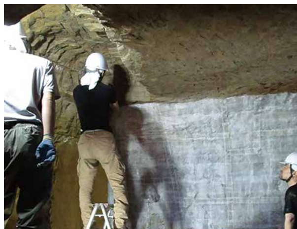
2. 奥壁上部 (天井) の掘削状況
