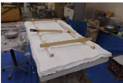
2. 【工程 9-(2)】石膏貼り込み完了(天井)
