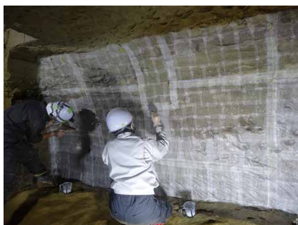
2-1. ビニロンクロス貼り込み作業
