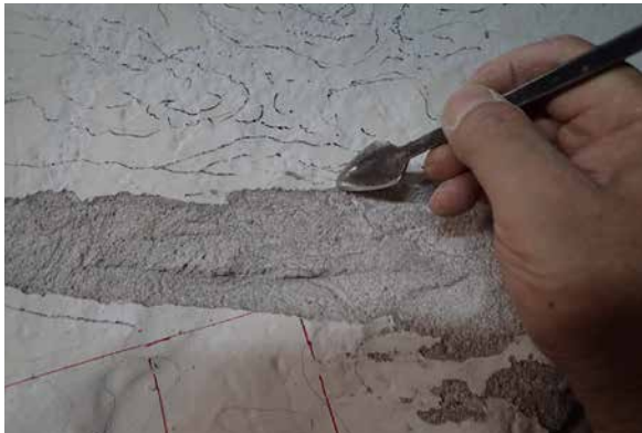
3. 【工程 10-(2)】作業工程⑥: 表面の加工
