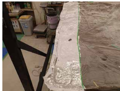
5. 【工程 10-(2)】シリコン樹脂塗布 (奥壁)
