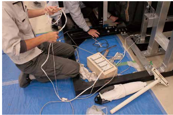
第 97 図 照明用スイッチ
