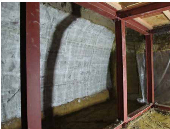
3. 支保工設置状況 (左: 奥壁)
