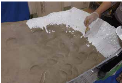
1. 【工程 9-(2)】石膏貼り込み(天井)
