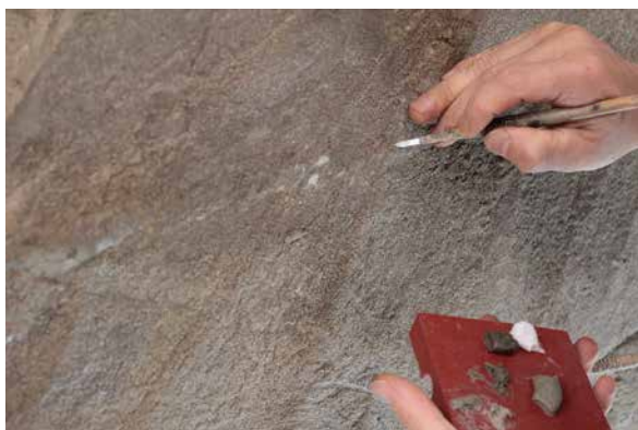
1. 【工程 7-(1)】目地埋め作業
