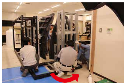
8. 【手順2】 陶板レプリカ取外し作業状況
