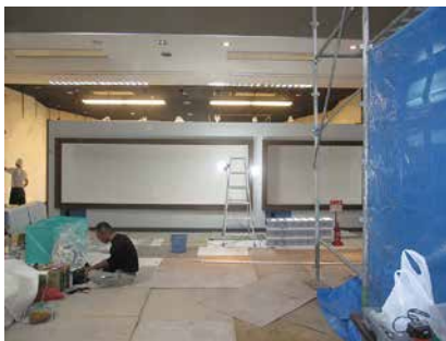
1. 展示室の改修状況
