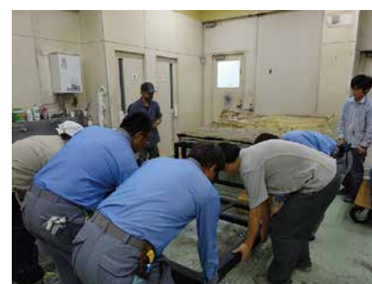
12. 【手順4-③】 左側壁底部骨組 取外し作業状況 3
