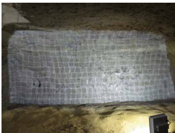
1-2. ガーゼ貼り込み作業完了状況
