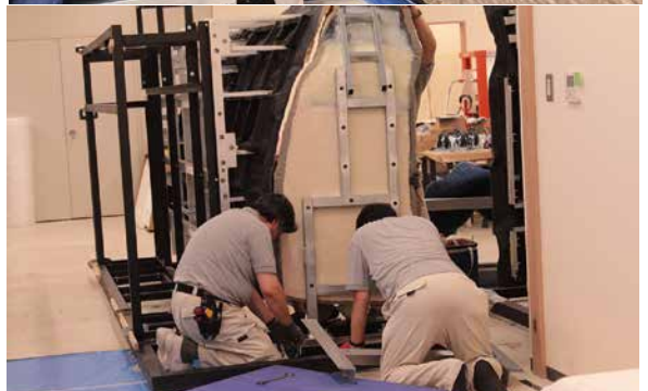
8. 【工程 10-(2)】設置作業状況
