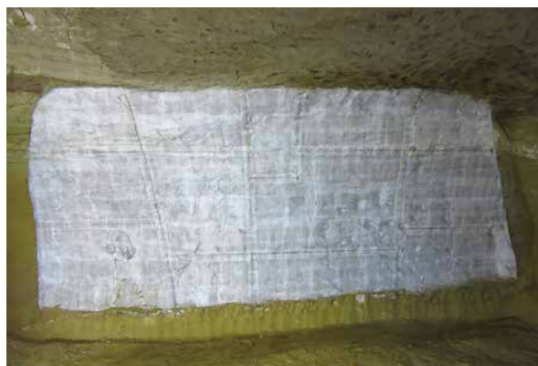
3-1. 分割ラインマーキング状況
