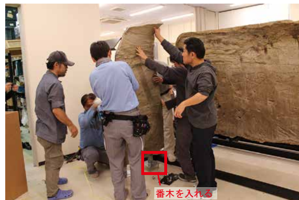
2. 【手順4】陶板レプリカ取外し作業状況 3
