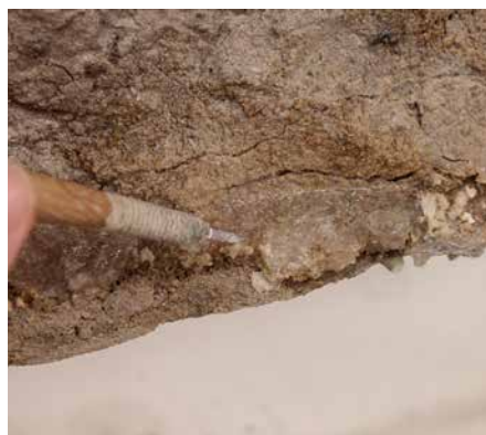
3. 【工程 7-(2)】アクリル樹脂塗布
