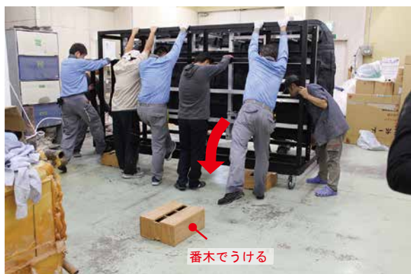
7. 【手順 3-②】 奥壁取外し準備作業状況 1
