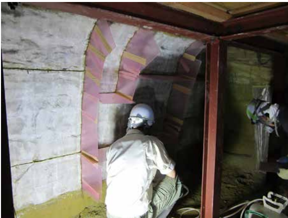
2-1. 塩ビシート差し込み作業
