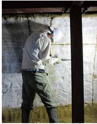
1-2. 分割ラインカット作業
