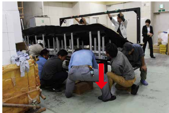
8. 【手順 3-②】 奥壁取外し準備作業状況 2
