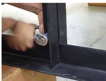
11. 【手順4-③】 左側壁底部骨組 取外し作業状況 2
