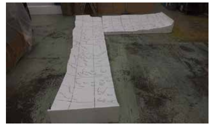
4. 【工程9-(1)】表面にタッチを入れる(天井)
