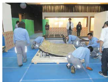
13. 【設置】左側壁 設置作業 1
