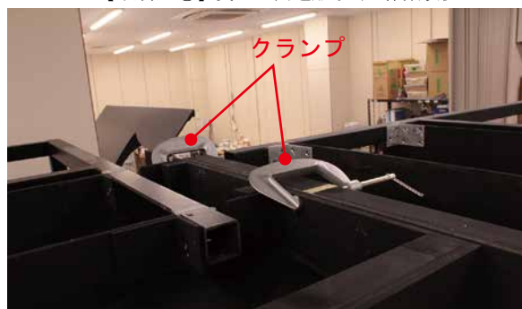
4. 【手順 7-①】 天井造形のクランプ留め (2 か所)
