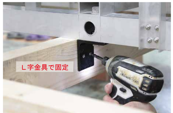
8. 【手順 4】運搬用木枠固定作業状況 3
