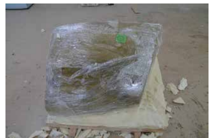
18. 【工程 1-(2)】梱包材の除去 (壁番号⑬)
