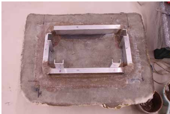
1. 【工程 3-(4)】骨組みの取付け①
