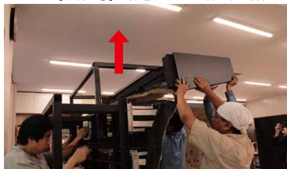
6. 【手順 7-③】 左側壁天井取外し作業状況 1
