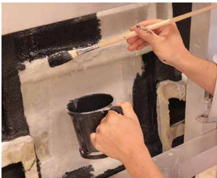
4. 【工程8-2】フレーム背面の塗装
