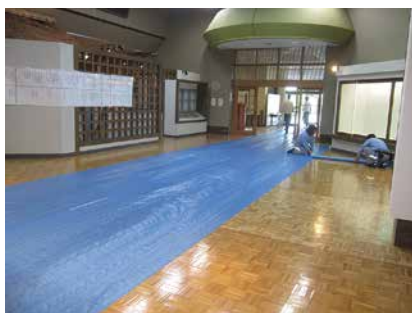
2. 【設置準備：養生】ホール
