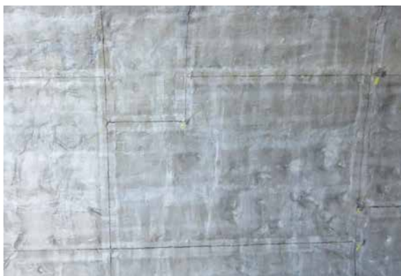
3-2. マーキング箇所（拡大）
