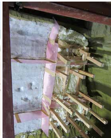
2-4. 木枠の取付状況
