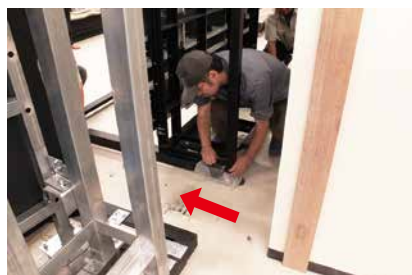
4. 【手順2】 作業スペース確保の状況
