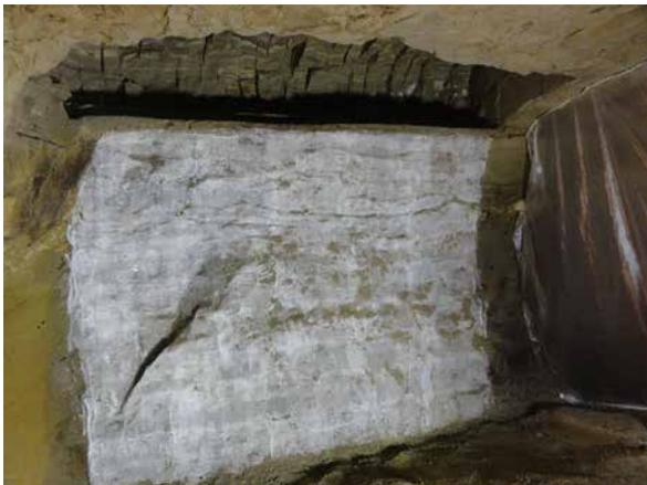
5. 工程3・4 ガーゼ・ビニルクロス貼り込み、天井掘削状況
