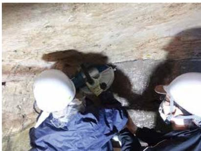
9. 工程 7 大型丸鋸による切れ目入れ作業
