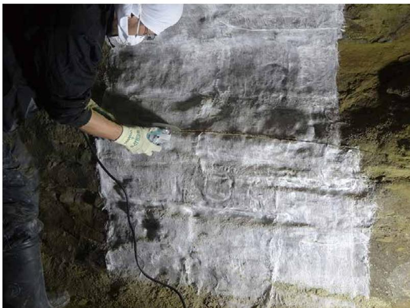
8. 工程 5 分割壁面の切れ目入れ作業
