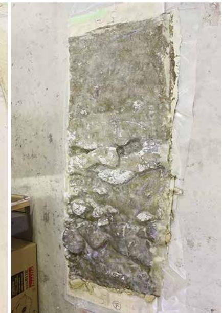
5. 工程 17 壁面の加工状況 (樹脂塗布後の状況: 壁面B)
