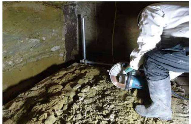
7. 工程 11 剥ぎ取り壁面の分割作業
