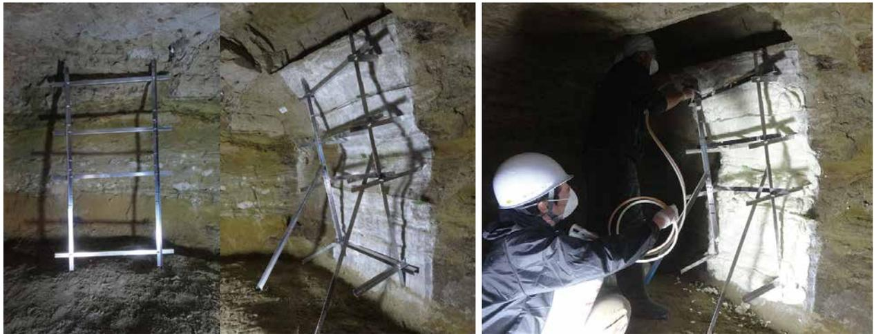
1. 工程6 受部の作成① フレーム作成・取付状況
