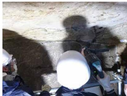
10. 工程 8 電動ハンマによる掘削作業
