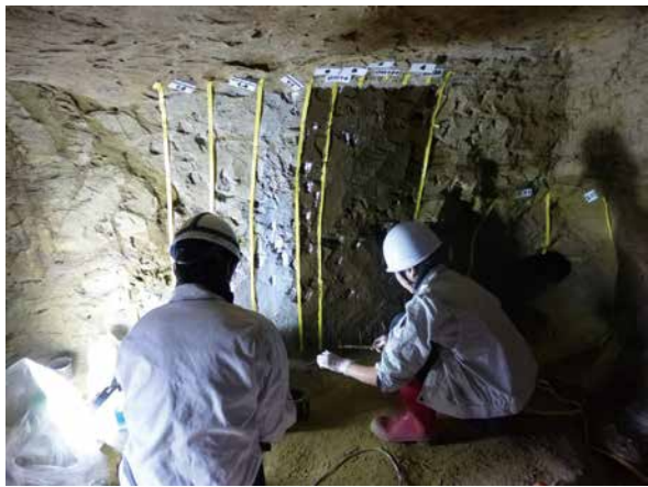
3. 壁面に対するシリコン塗布
