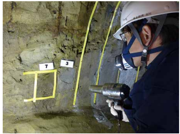
2. 壁面の乾燥試験
