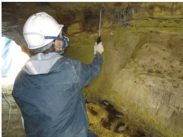
7. 線刻画への施工 (OM25による強化処置)
