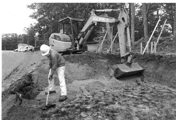
8. 火山灰除去作業状況 W→
