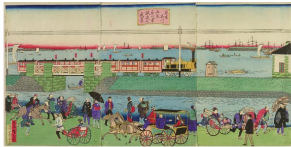
高輪築堤石組遺構と三代歌川広重錦絵（港区ウェブサイトより）
