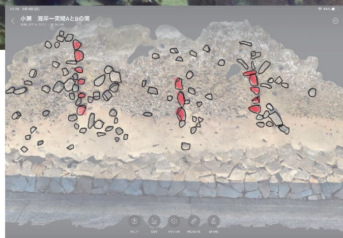
図20 小瀬加藤家石丁場の突堤遺構（推定）。赤枠が石列の一部。面を揃えている。iPad LiDARにて取得した3Dモデルにスケッチを書き込み
