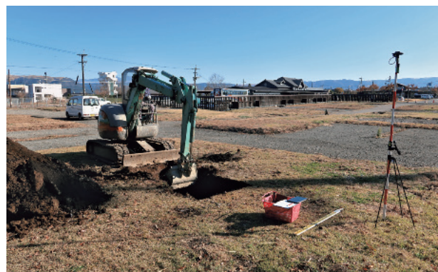
図-4 トレンチ掘削の様子
