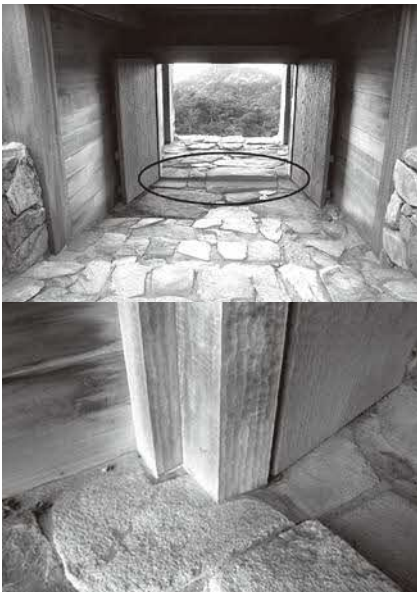
図5（上）図6（下） 備中鬼ノ城西門：花崗岩切石唐居敷・蹴放し・石敷き床面・図5の手前が石階段
