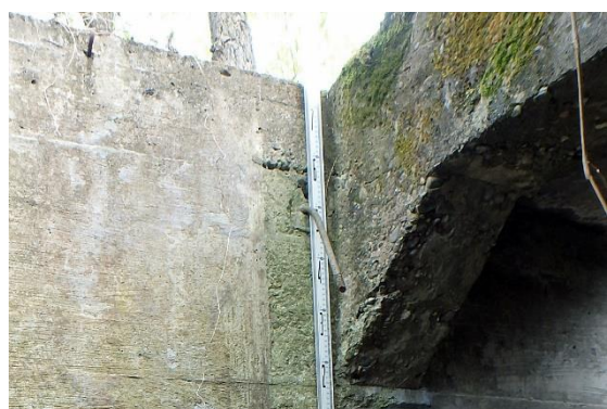
図 27. 同上・的用開口部東壁のボルト (NW→SE) 同上 * ボルトは折れ曲がった状態
