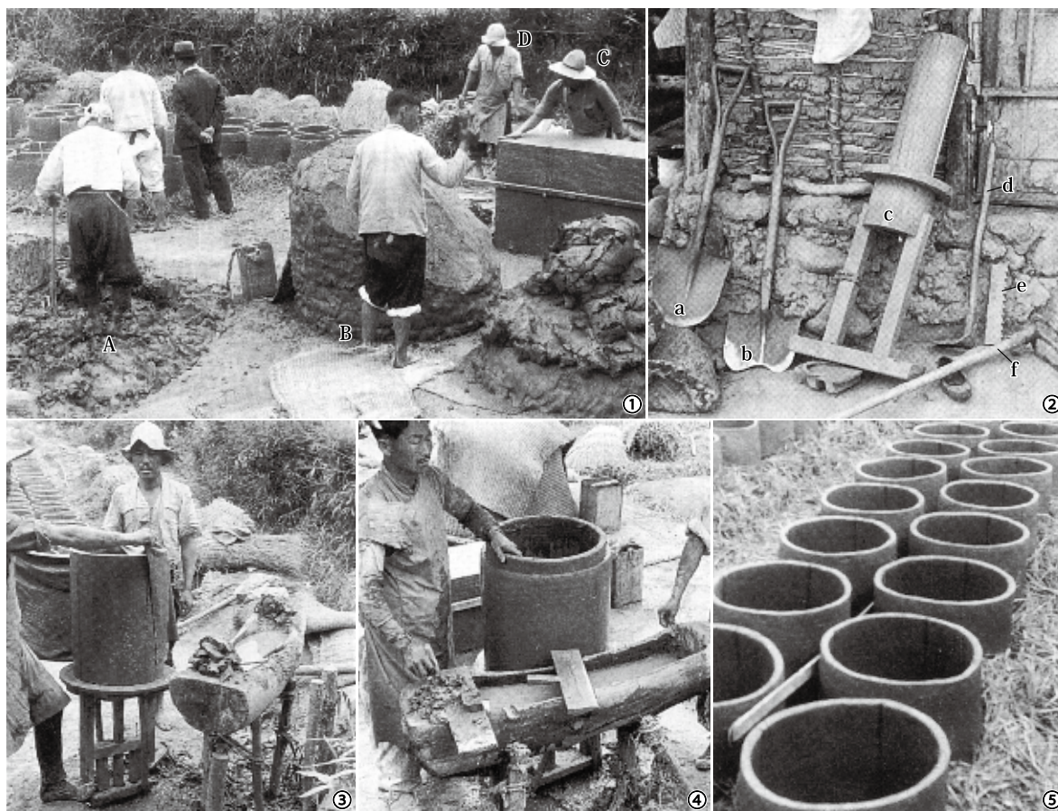
図5 韓国華嚴寺覺皇殿修理工事の造瓦例（藤島1939）
