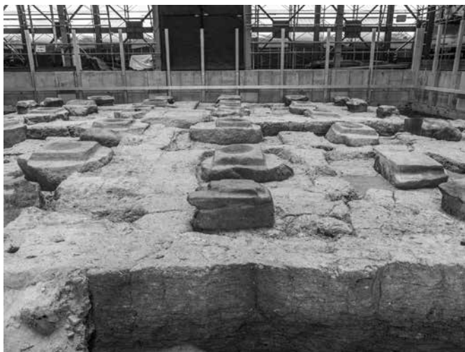
Fig.32 基壇西側における不同沈下した礎石（北から）
