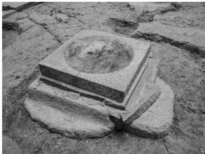
Fig.33 明治修理時に追加した礎石「ほ二」の柱座 (南西から)
