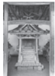
図42 菅神社本殿 正面(南から)
