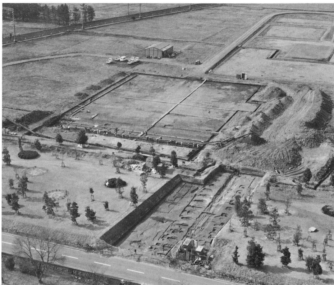
第 171 次調査全景（推定第一次東朝集殿地区、北東から）
