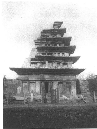
第6図 弥勒寺石塔修理後
