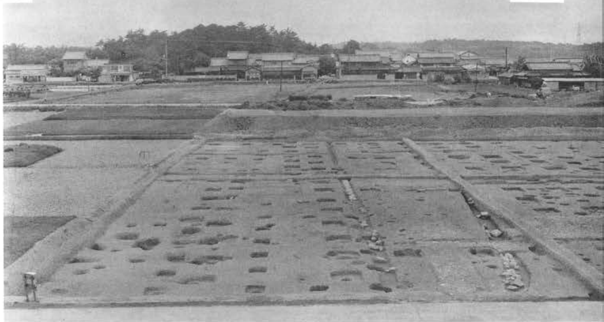
西半部 南から
