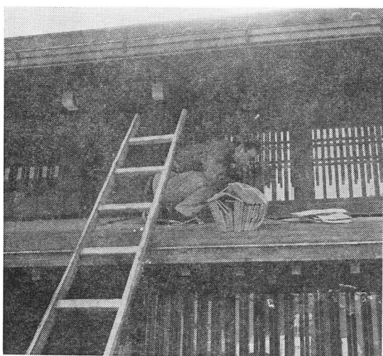
2—33 こけら葺の庇とふきかえ作業
