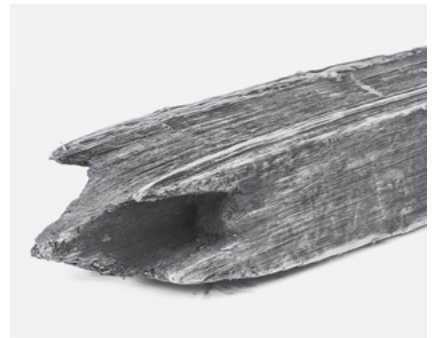
図243 部材上端の腐朽と仕口の痕跡
