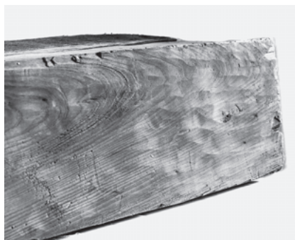
図245 側面のヤリガンナ痕跡
