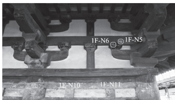
図I-42 初層腰組北面試料採取箇所
