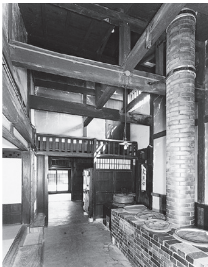
図39 主屋通り土間
