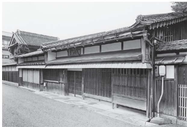
図36 長谷川家住宅主屋外観
