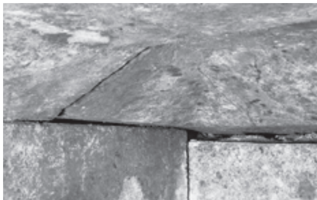
図170 低い南壁石（右下）と天井石1（右上）の傾き（北西から）
