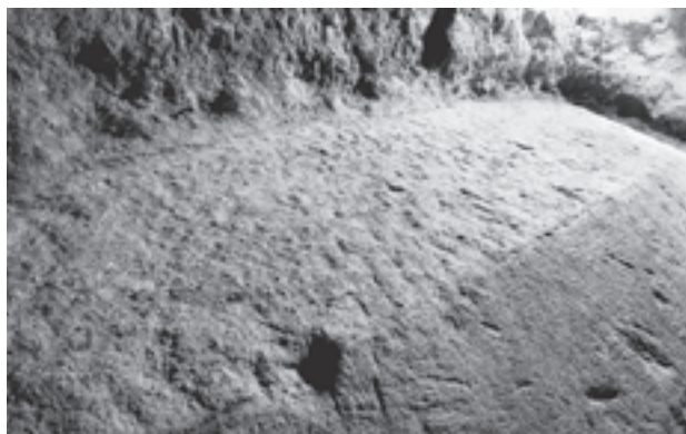
図173 天井石1上面のノミ小叩きの痕跡(南西から)
