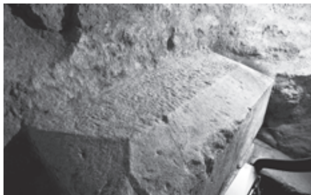
図172 天井石1の加工の精粗(南西から)
