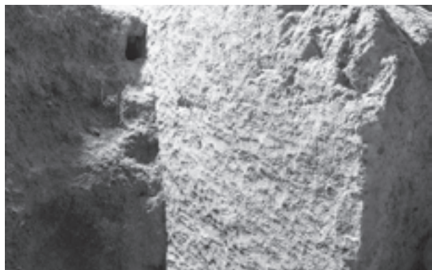
図174 天井石1西側面のチョウナ削りの痕跡(南西から)
