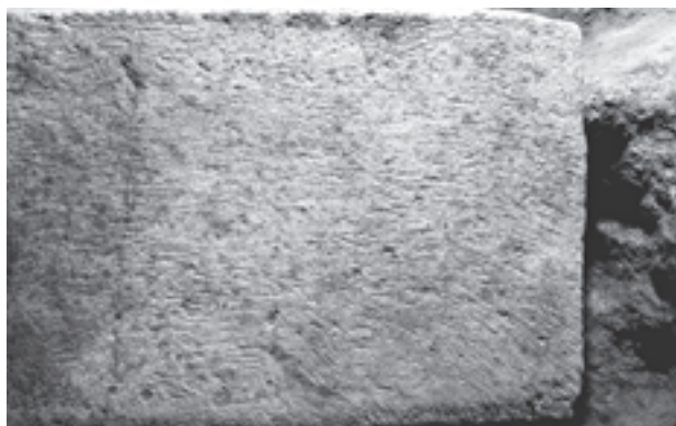
図175 天井石1前面のチョウナ叩きの痕跡(南から)
