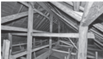
図45 浄土院拝殿の小屋裏
