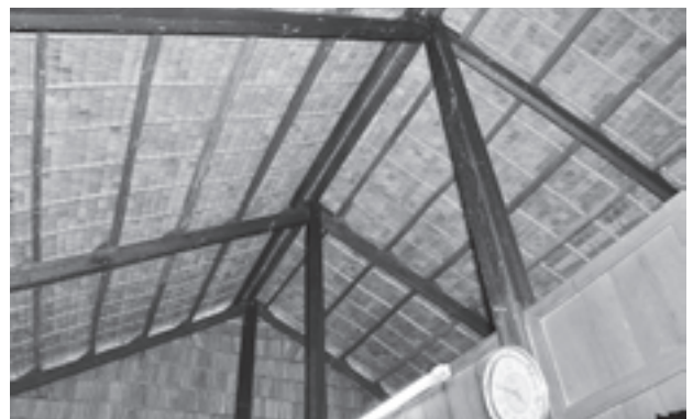
図38 ヤシ葺民家における棟持柱形式の架構
