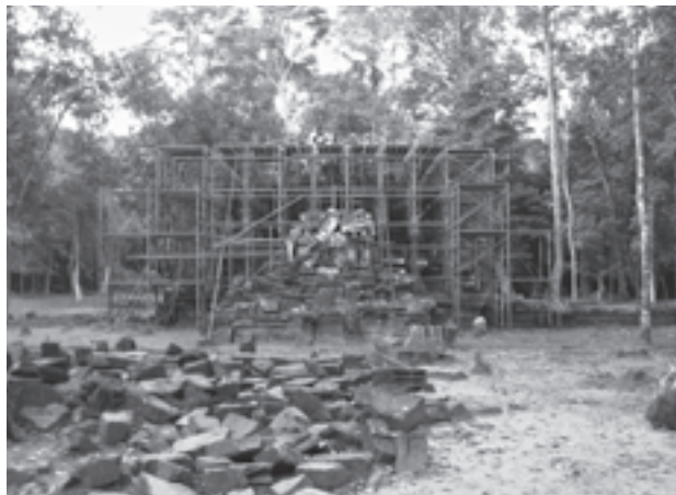
図10 南祠堂現状写真（2012年3月：南から）
