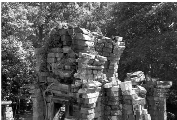
図22 中央祠堂頂部の破損状況
