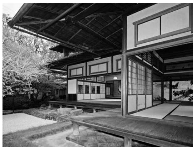
図11 宙を浮く軒桁（角屋松の間、京都市、大正15年）
